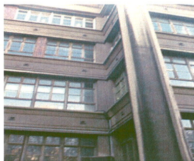
Façade arrière de l'aile Physique joint de dilatation
