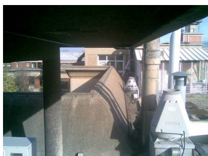
Corniche formant garde-corps et présentant des épaufrures, aciers apparents ...
